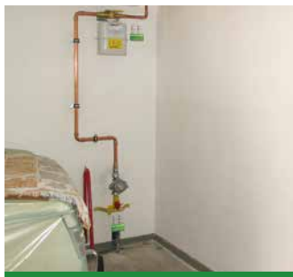
Freier Zugang ermöglicht schnelles Absperren.
