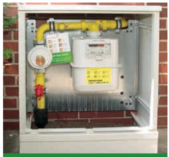
Hausanschlusskasten
