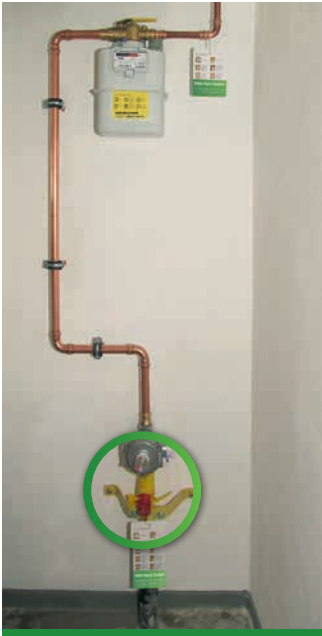
Hauptabsperreinrichtung
